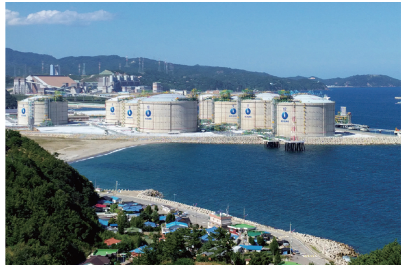
삼척 LNG 저장탱크 및 부대설비
