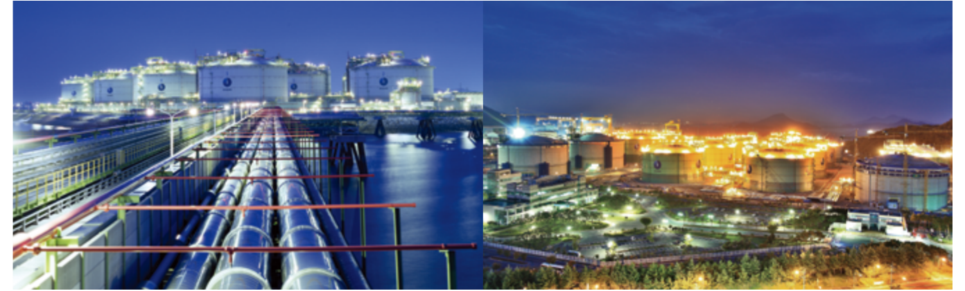
인천 LNG 인수기지
